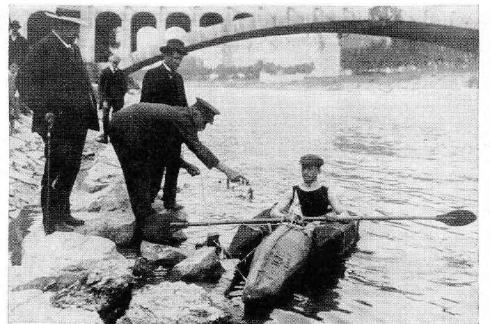
Eine Versuchskonstruktion, ein Faltboot von 1912 mit seitlichen Schwimmern, die ein Kentern des Bootes verhindern sollten
